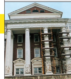
restauration de grandes colonnes à l'aide de LiquidWood et de WoodEpoxy.
